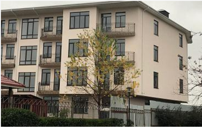
г. Сочи, Адлерский район, ул. Трубачева
