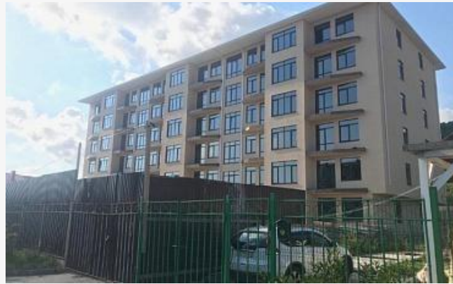
г. Сочи Адлерский район, ул. Трубачева
