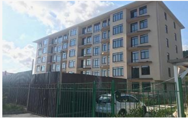
г. Сочи Адлерский район, ул. Трубачева
