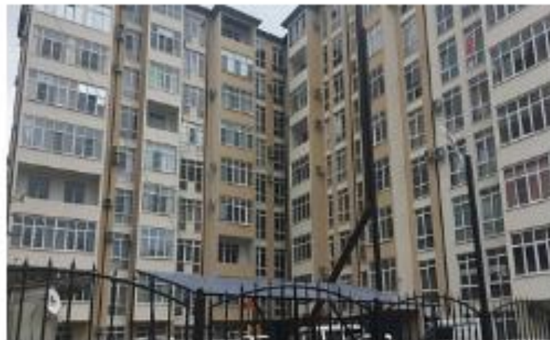
г. Сочи, Адлерский район, ул. Нагорный Тупик, 13
